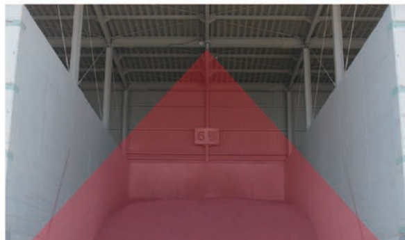
各ピットに3Dレーザースキャナー固定配置
