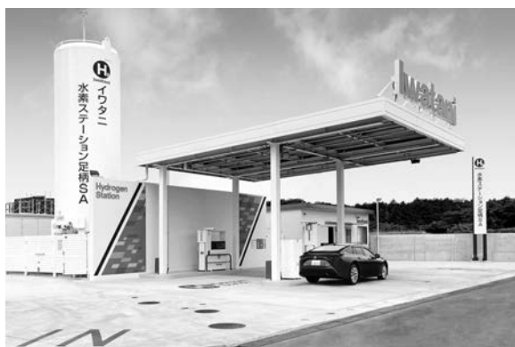
イワタニ水素ステーション足柄 SA (© Iwatani Corporation)
