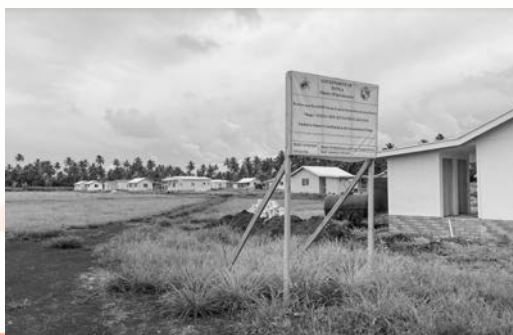
トンガ政府が被災した方々へ建設(中)の仮設住宅
